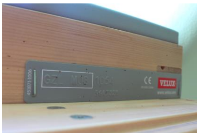
Štítek na starší generaci střešních oken VELUX. Štítek okna rozměru MK08 (78/140 cm)
